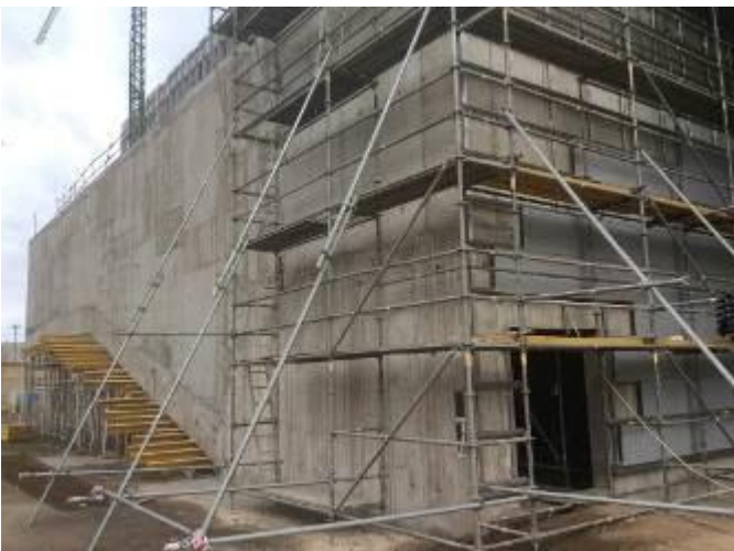
Hormigonado Muro auditorio
