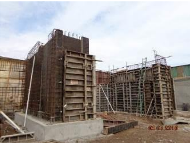
Avance obras civiles Jardín Infantil
