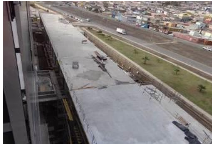
Avances hormigonado losa sector de cafetería y auditorio
