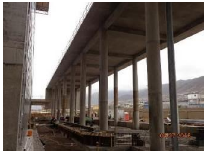
Obra gruesa cafetería
