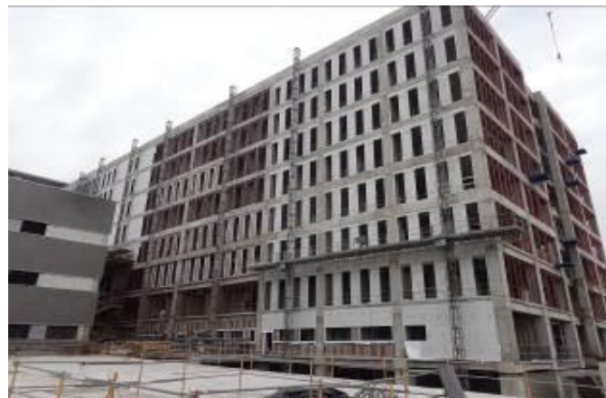
Obra gruesa TH
