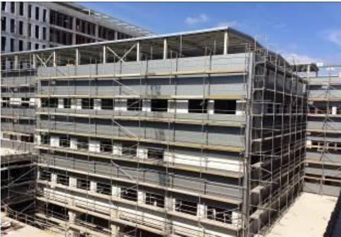
Obra gruesa sector UPC
