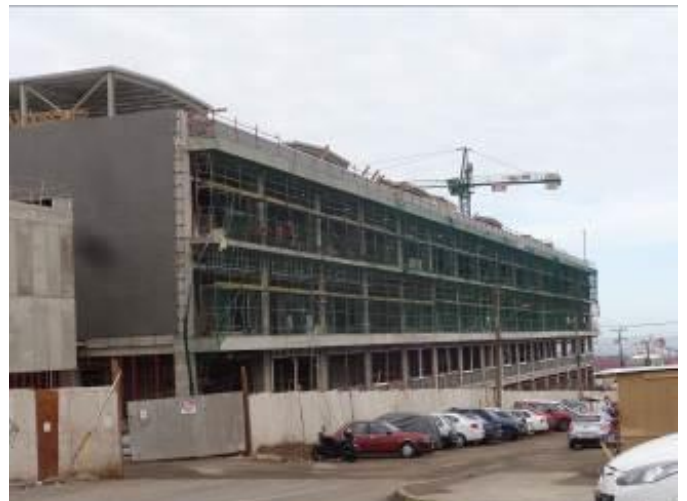
Obra gruesa en edificio CDT
